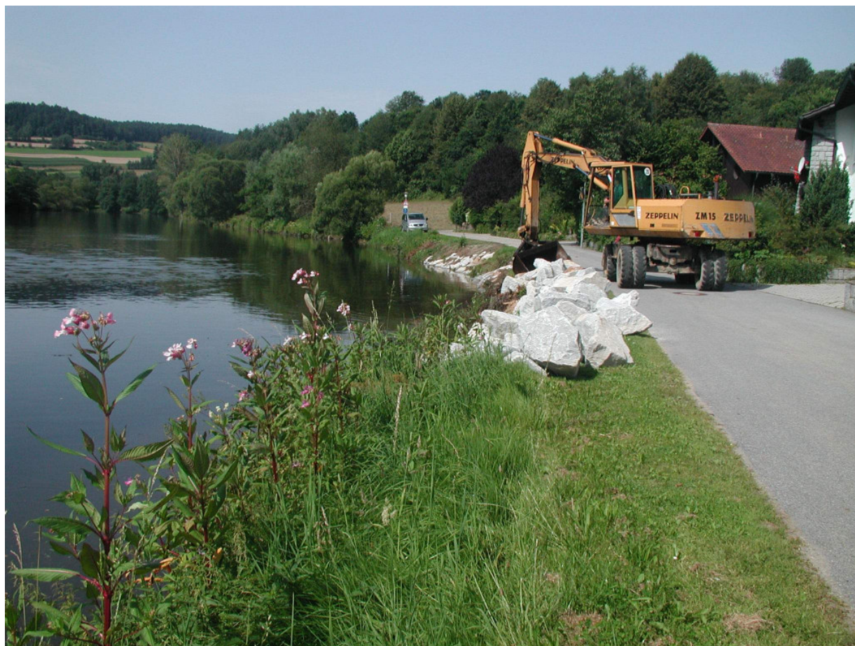
Bild: Der Bagger am Ufer des Regens, bei der Behebung des Schadens.
