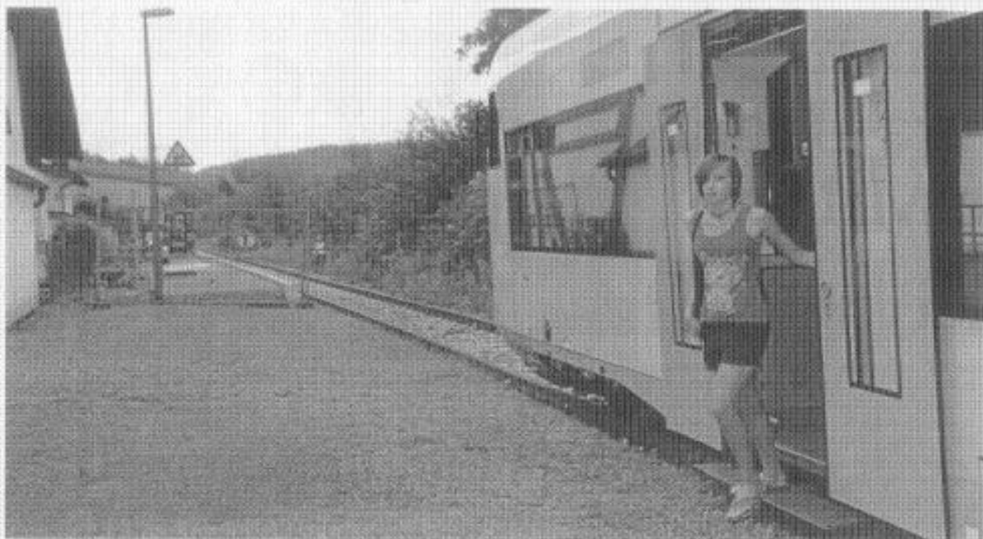
Bisher treten Zugreisende, die in Chamerau aussteigen, auf einen unebenen, mit Gras bewachsenen Bahnsteig. Derzeit wird der Belag saniert und der Bahnsteig erhöht. Foto: Straßer
