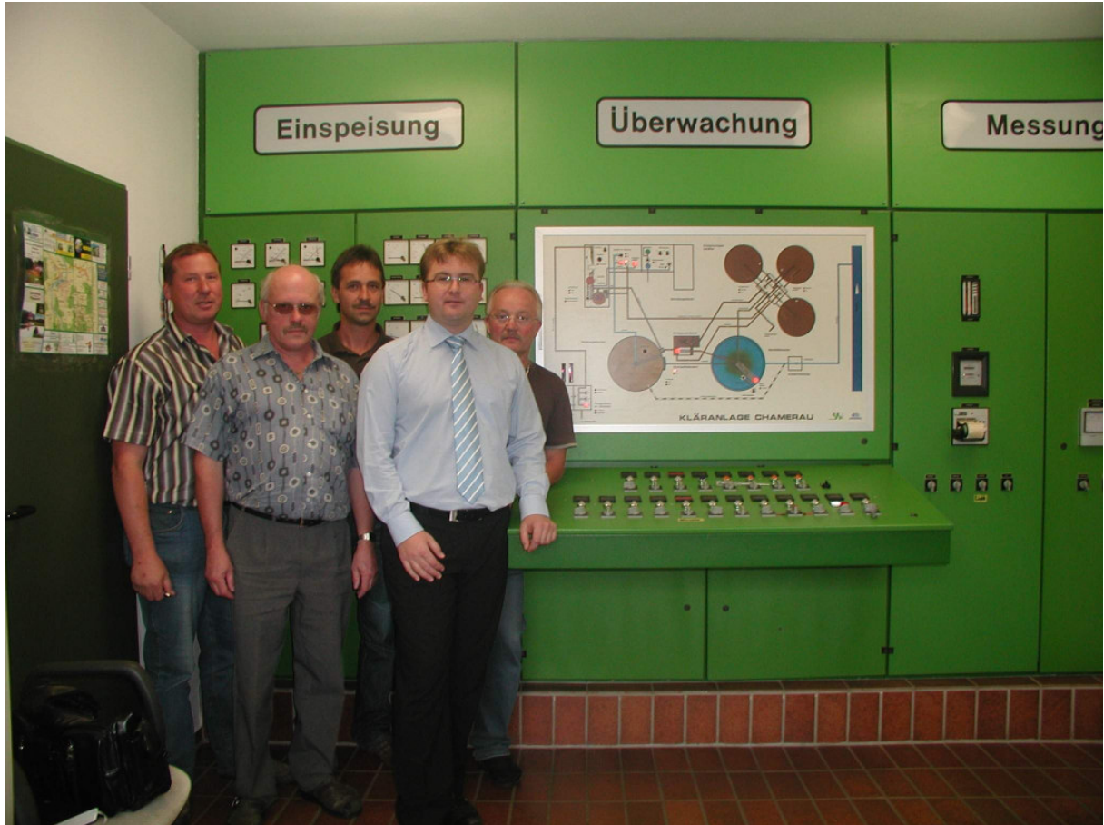
Bild: Die Bürgermeister Stefan Baumgartner und Christian Glonner; Klärwärter Max Wanninger, Geschäftsstellenleiter Reinhold Fischer und Franz Heigl von der ausführenden Firma K+B, bei der Abnahme in der Kläranlage in Chamerau.
