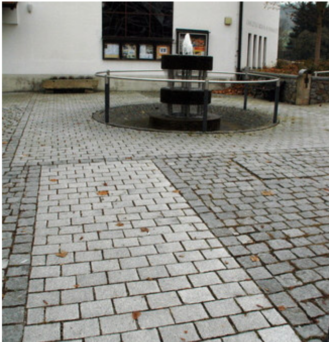
Für die Auswechslung des Pflasters vor der Kirche und den Bau von Geländern gewährt die Gemeinde 3500 Euro Zuschuss.
